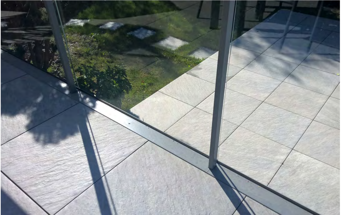
VUE INTÉRIEURE : Profil de raccordement au plancher
