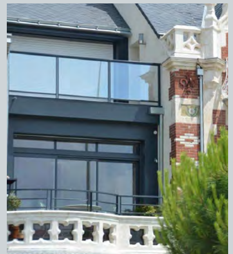
Garde-corps OXYTAL à remplissage clair complet avec montants ajourés
