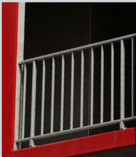
Garde-corps ARMOR à barreaudage vertical complet
