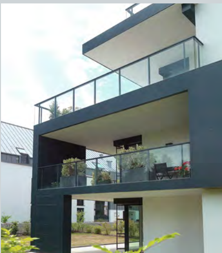
Garde-corps INTEGRAL à remplissage 44/2 clair.
