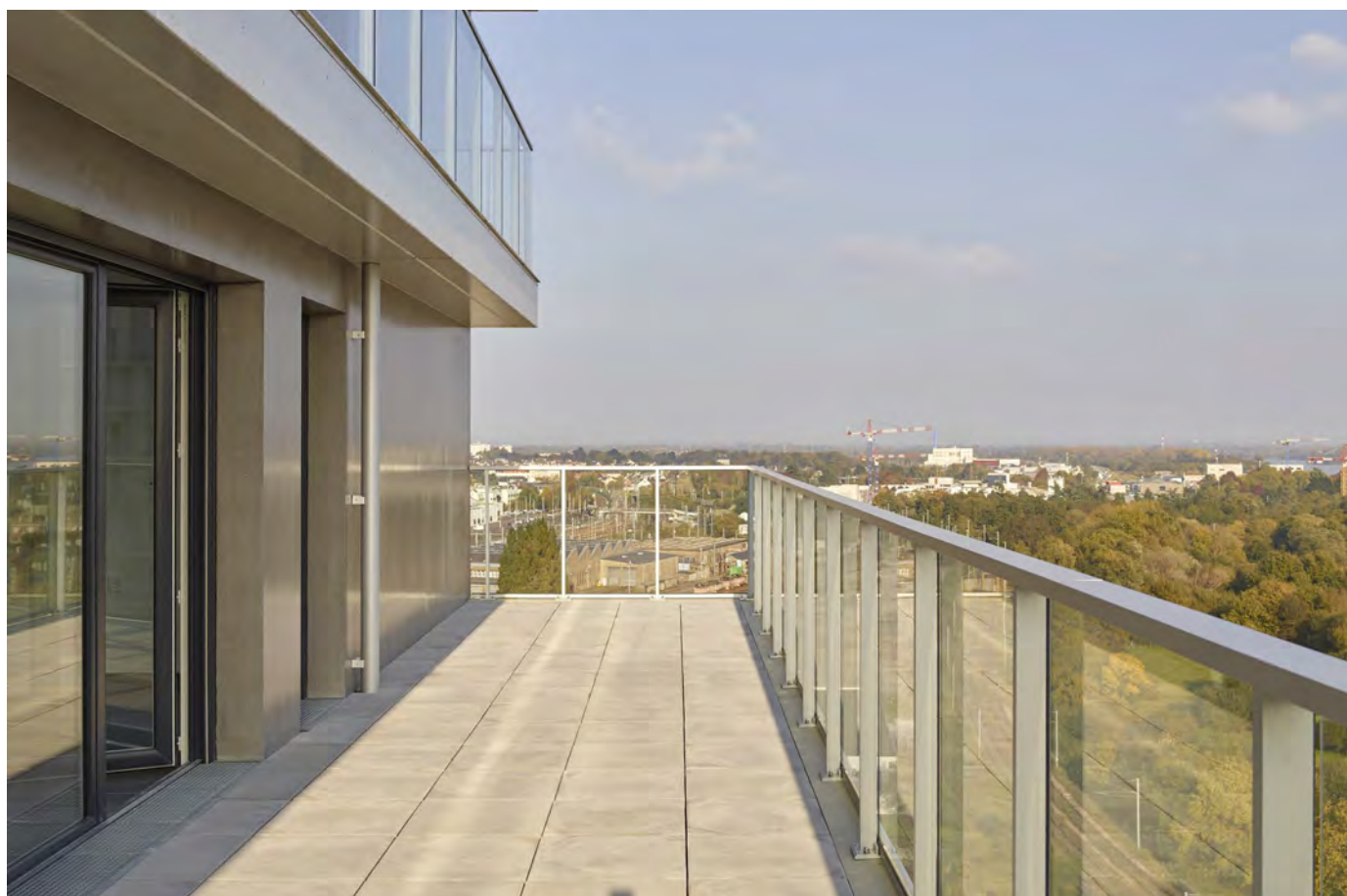
TOUR AMAZONIE - ZAC Pré-Gauchet - lot 3B - Bât C à NANTES - Architectes : a/LTA.
