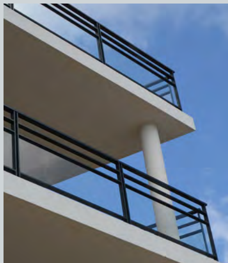
Garde-corps OXYTAL à remplissage clair avec montants accolés et 1 lisse intermédiaire
